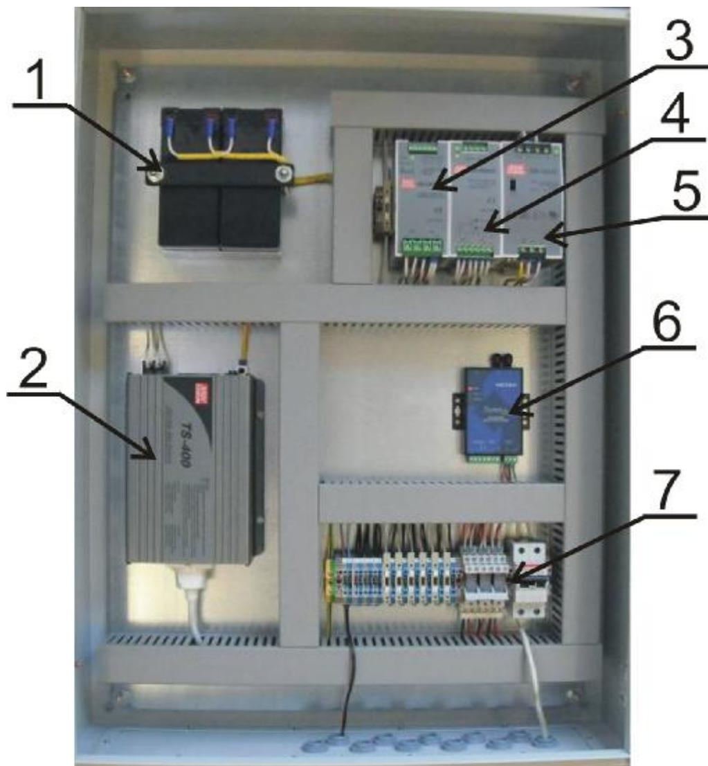
**Рис.5 . Пример шкафа управления сигнализацией и вентиляцией (вид изнутри) системы контроля содержания элегаза в помещении КРУЭ.**
